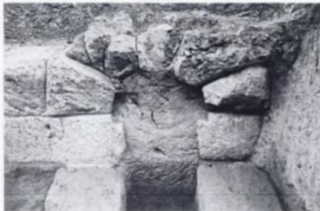
Fig. 4. Via Ostiense, viadotto ad Acilia: secondo arco del condotto di smaltimento delle acque defluenti dai Monti di S. Paolo.
