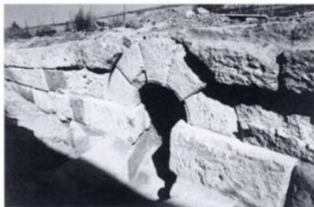
Fig. 1. Via Ostiense: veduta del viadotto ad Acilia, con uno degli archi.
