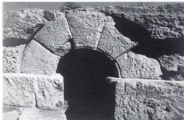
Fig. 3. Via Ostiense, viadotto ad Acilia: arco di sbocco del condotto più settentrionale di smaltimento delle acque defluenti dai Monti di S. Paolo.
