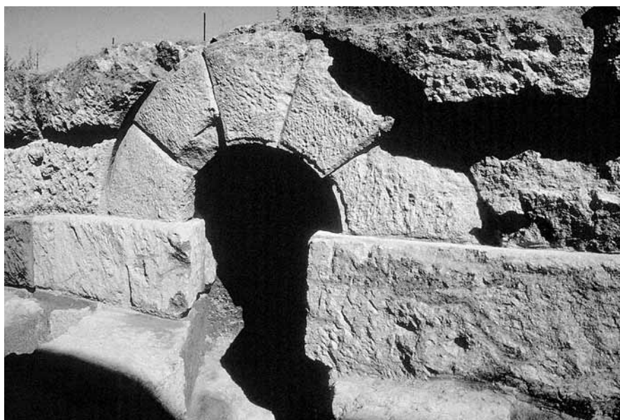
Fig. 9 – Acilia, scavi Pellegrino : ponticello su un rivo nella sostruzione della via Ostiense.
